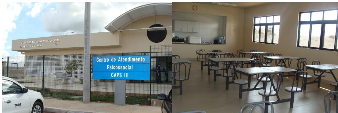
Fachada do CAPS II – Samambaia
