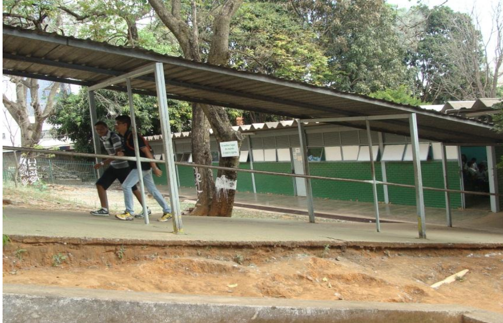
Figura 7 – Rampa de acesso às salas de aula - CEM EIT - Taguatinga.
